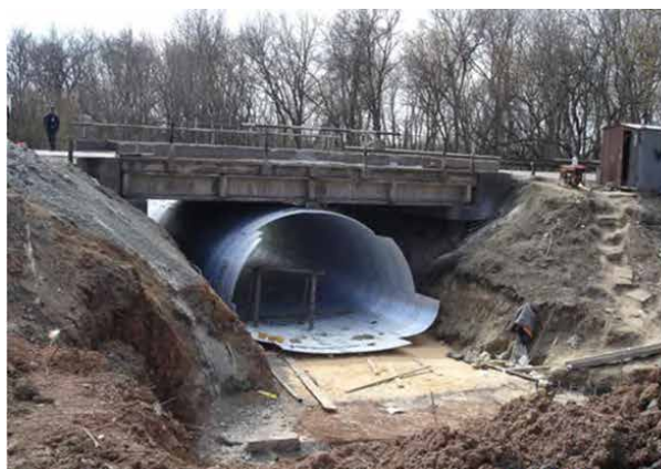
Rys. 3: Odbudowa mostu na drodze krajowej
