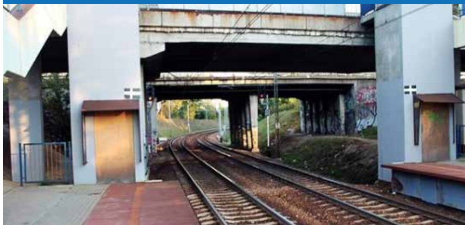
Rys. 2.38. Przykład windy „zabitej dyktą” uniemożliwiającej dostęp do pociągu osobom niepełnosprawnym
