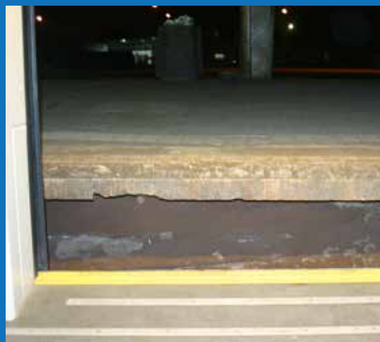
Rys. 2.47. Przykłady niedostępności wagonu dla osób niepełnosprawnych (podłoga wagonu położona poniżej powierzchni peronu)
