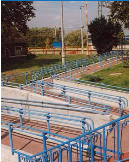
Rys. 2.9. Przykład rozwiązania pochylni na stacji Niepokalanów
