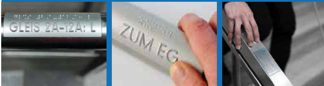
Rys. 3.6. Elementy dotykowe na poręczach przeznaczone dla osób niepełnosprawnych
