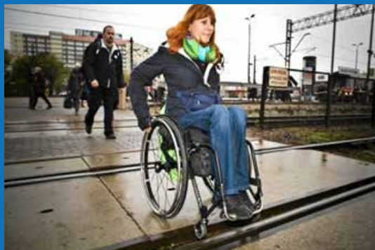
b) Kółka wózka inwalidzkiego wpadające między szynę a płytę przejazdową
