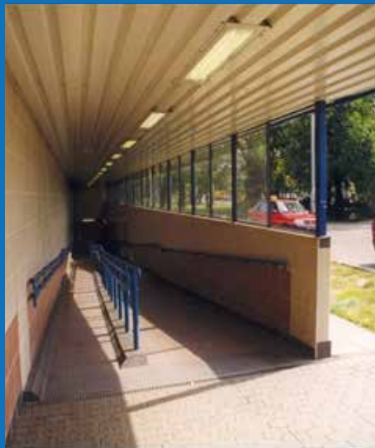
Rys. 2.9. Przykład rozwiązania pochylni na stacji Niepokalanów
