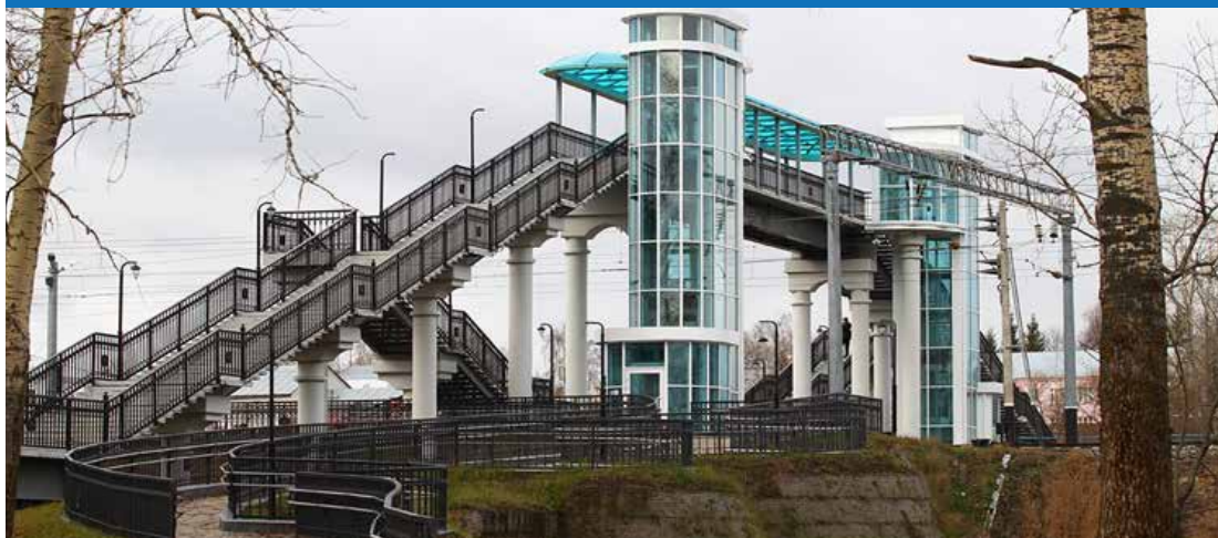
Rys. 2.31. Przykład zmodernizowanej kładki nad torami kolejowymi i jej dostosowanie do potrzeb osób niepełnosprawnych poruszających się na wózkach inwalidzkich
