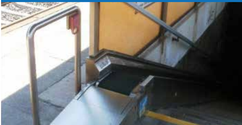
Rys. 3.5. Taśmociąg ułatwiający przemieszczanie ciężkiego bagażu z przejścia podziemnego na peron
