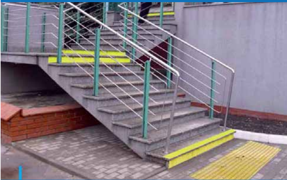
Rys. 2.23. Prawidłowe oznakowanie schodów w przestrzeni publicznej
