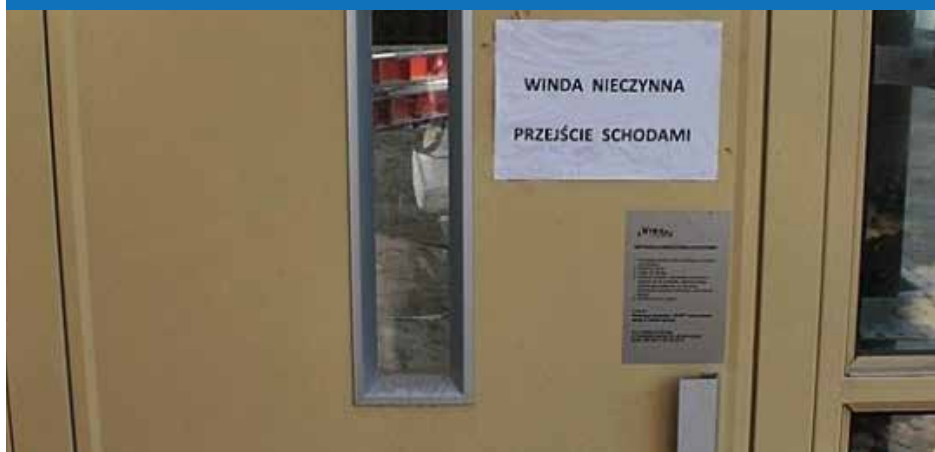
Rys. 2.37. Przykład uszkodzonego urządzenia uniemożliwiającego dostęp do peronu osobom niepełnosprawnym
