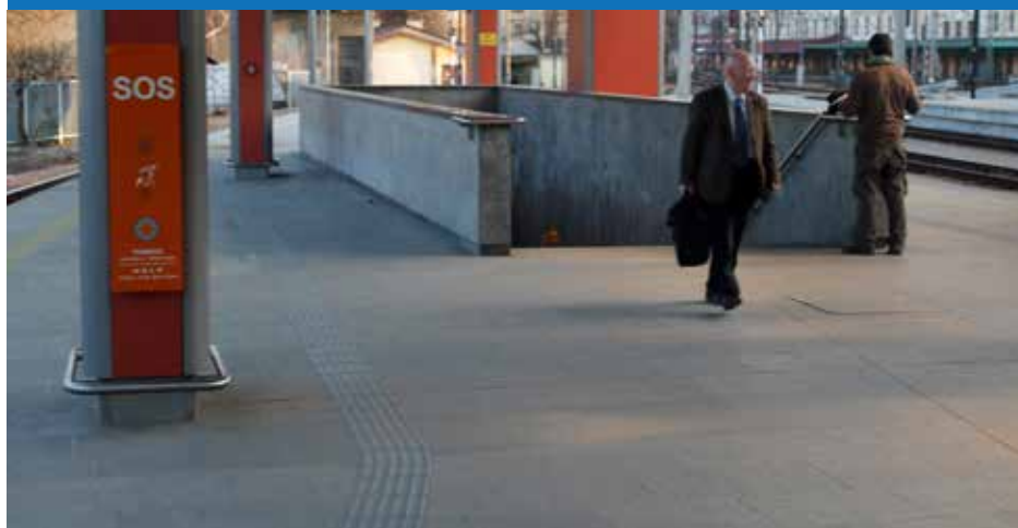
Rys. 2.72. Błędnie wyznaczone ścieżki dotykowe na peronie 5. stacji Kraków Główny (fot: Adam Zajac)
