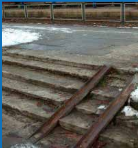
Rys. 2.24. Przykłady uszkodzonych schodów na dworcach kolejowych
