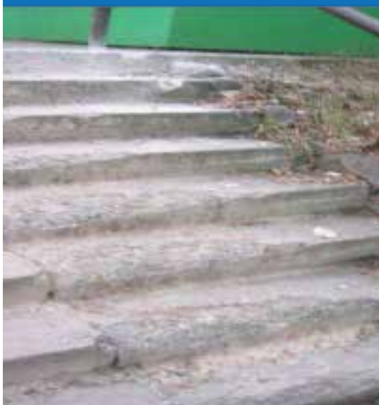
Rys. 2.24. Przykłady uszkodzonych schodów na dworcach kolejowych
