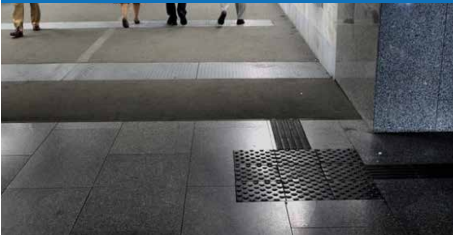
Rys. 2.14. Ścieżka dotykowa urywa się w przejściu podziemnym dworca
