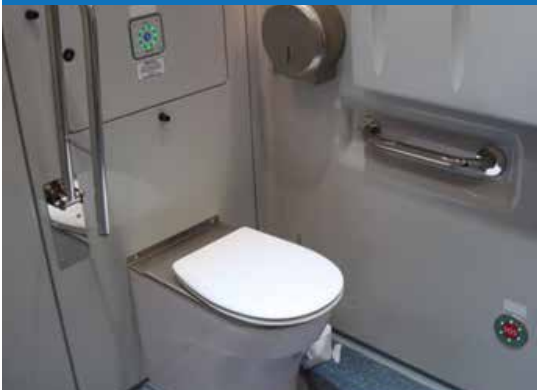
a) Toaleta w zmodernizowanym wagonie 2. klasy typu 111A
